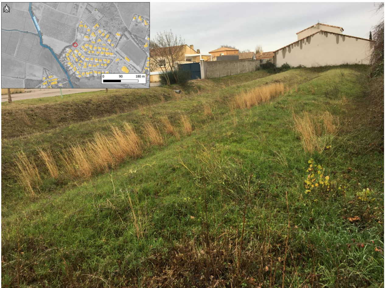
Figure 13 : Localisation et vue du bassin du lotissement le Saint-Rome
