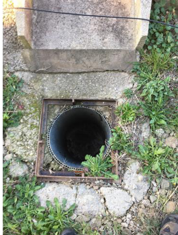
Figure 24 : Photos d'un dispositif d'acheminement vers la noue obstrué (à gauche), et du regard de collecte des eaux sans tampon (à droite).
