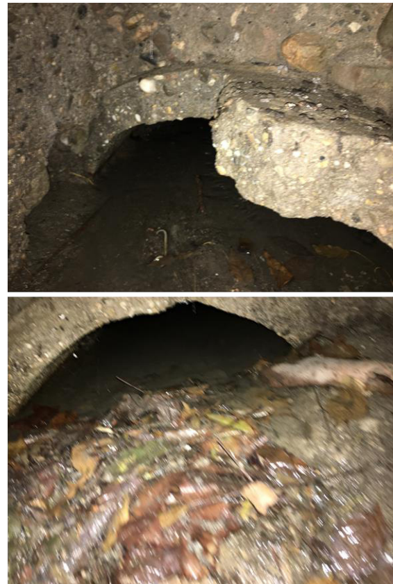
Figure 32 : Photos du regard non sécurisé à l'exutoire 06 (gauche) et des conduites affaissées et ensablées au niveau de la grille jouxtant le parc (droite)
