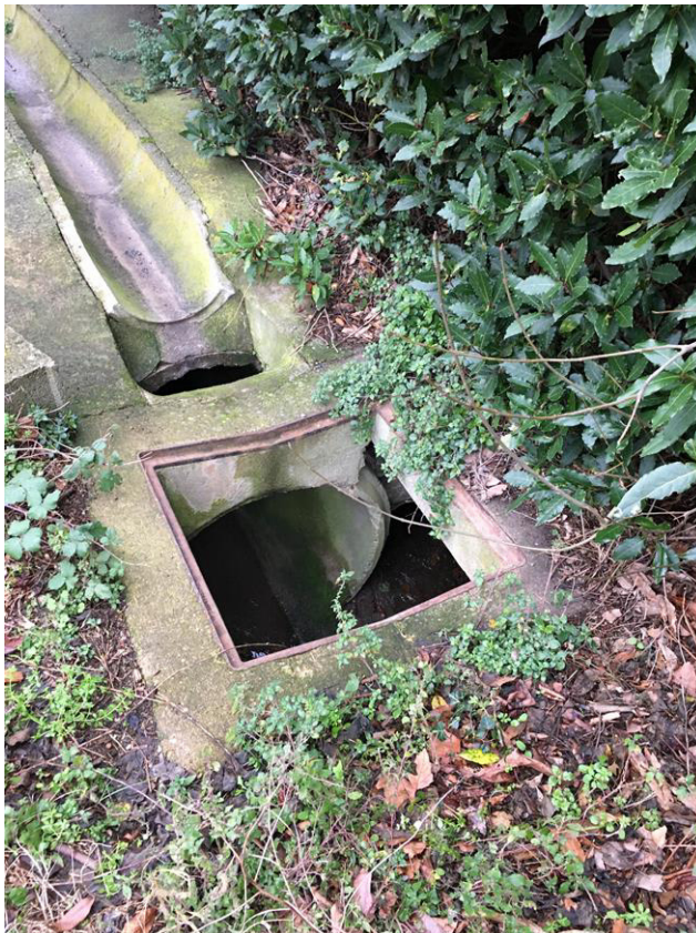
Figure 32 : Photos du regard non sécurisé à l'exutoire 06 (gauche) et des conduites affaissées et ensablées au niveau de la grille jouxtant le parc (droite)
