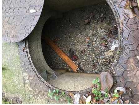
Figure 30 : Vue du dépôt sédimentaire au droit de l'exutoire 05
