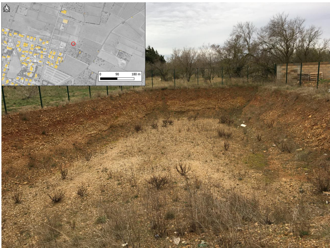
Figure 16 : Localisation et vue du bassin du lotissement le Clos des Oliviers
