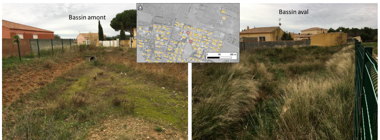
Figure 15 : Localisation et vues des bassins de l'Oliveraie
