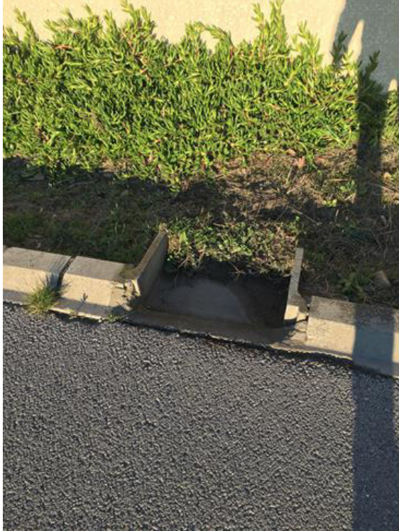
Figure 24 : Photos d'un dispositif d'acheminement vers la noue obstrué (à gauche), et du regard de collecte des eaux sans tampon (à droite).
