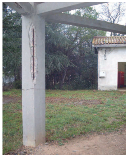
Génie civil extérieur
