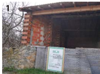
Réhabilitation en cours
